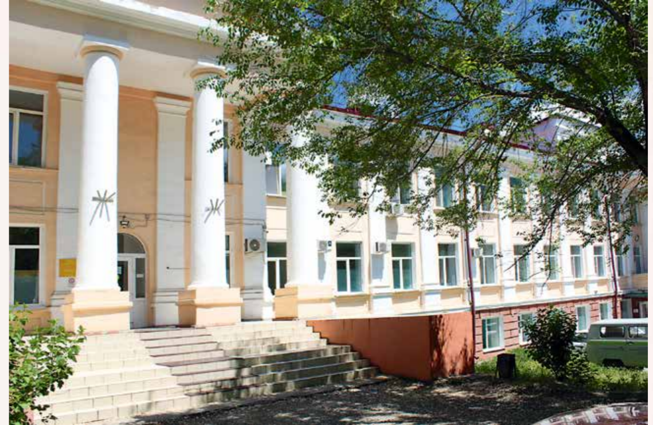
Здание больницы после реконструкции
