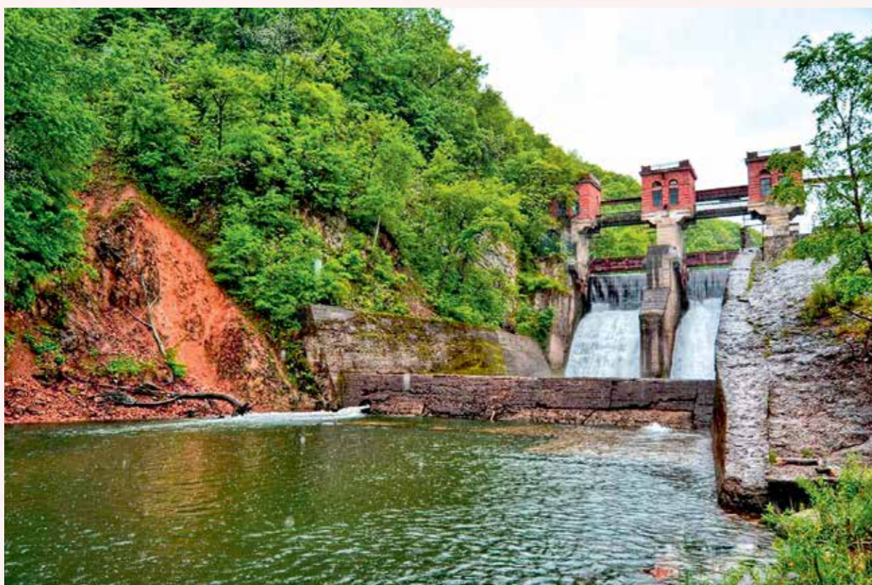
Водосброс Партизанской ГРЭС
